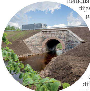
PĀRBŪVĒTA CAURTEKA LĪGATNĒ – 2. vieta konkursā Latvijas Būvniecības Gada balva 2021 nominācijā Inženierbūve – pārbūve.
